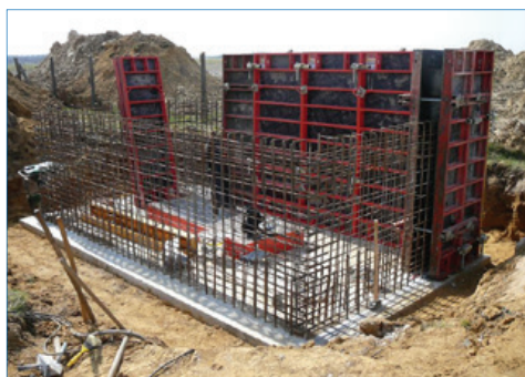
(Fotók az építés közbeni állapotot mutatják)
